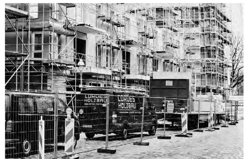
Der hybride Neubau in Berlin-Wedding wurde unter Mitwirkung mehrerer DHV-Mitgliedsunternehmen errichtet. FOTOS: ACHIM DATHE FÜR DEN DHV
